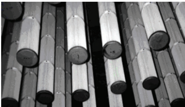
Figura 6 - Mangas plissadas no filtro.
