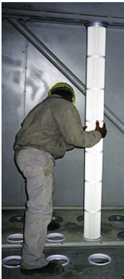
Figura 5 - Colocação de mangas plissadas no filtro.
